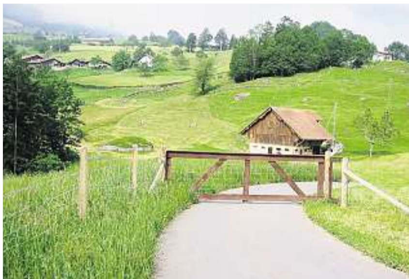
Neue Inertstoffdeponie: Für das neu eingezonte Gebiet «Summerau» nahe der Goldauer Bernerhöhe hat die Schelbert AG dieser Tage bei der Gemeinde Arth das Baugesuch eingereicht.
